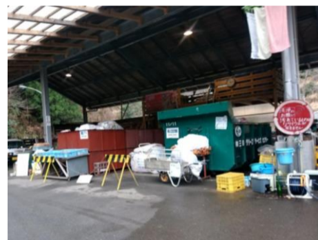
住民が各自持ち込むゴミステーション
